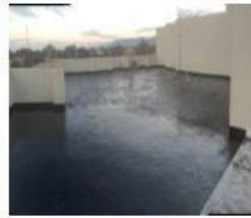
Como imprimante previo a la colocación de un manto asfáltico.
